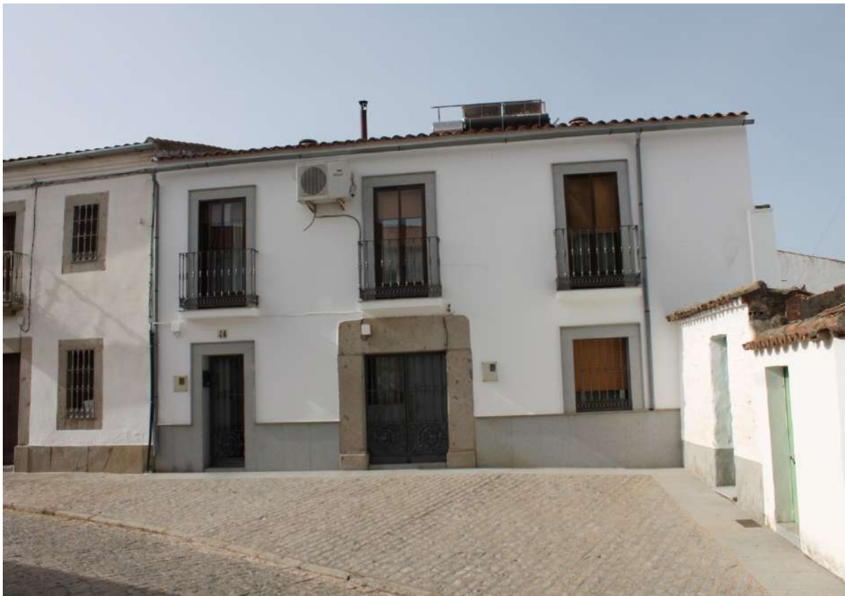
Puerta central tradicional en la Calle Iglesia nº4
