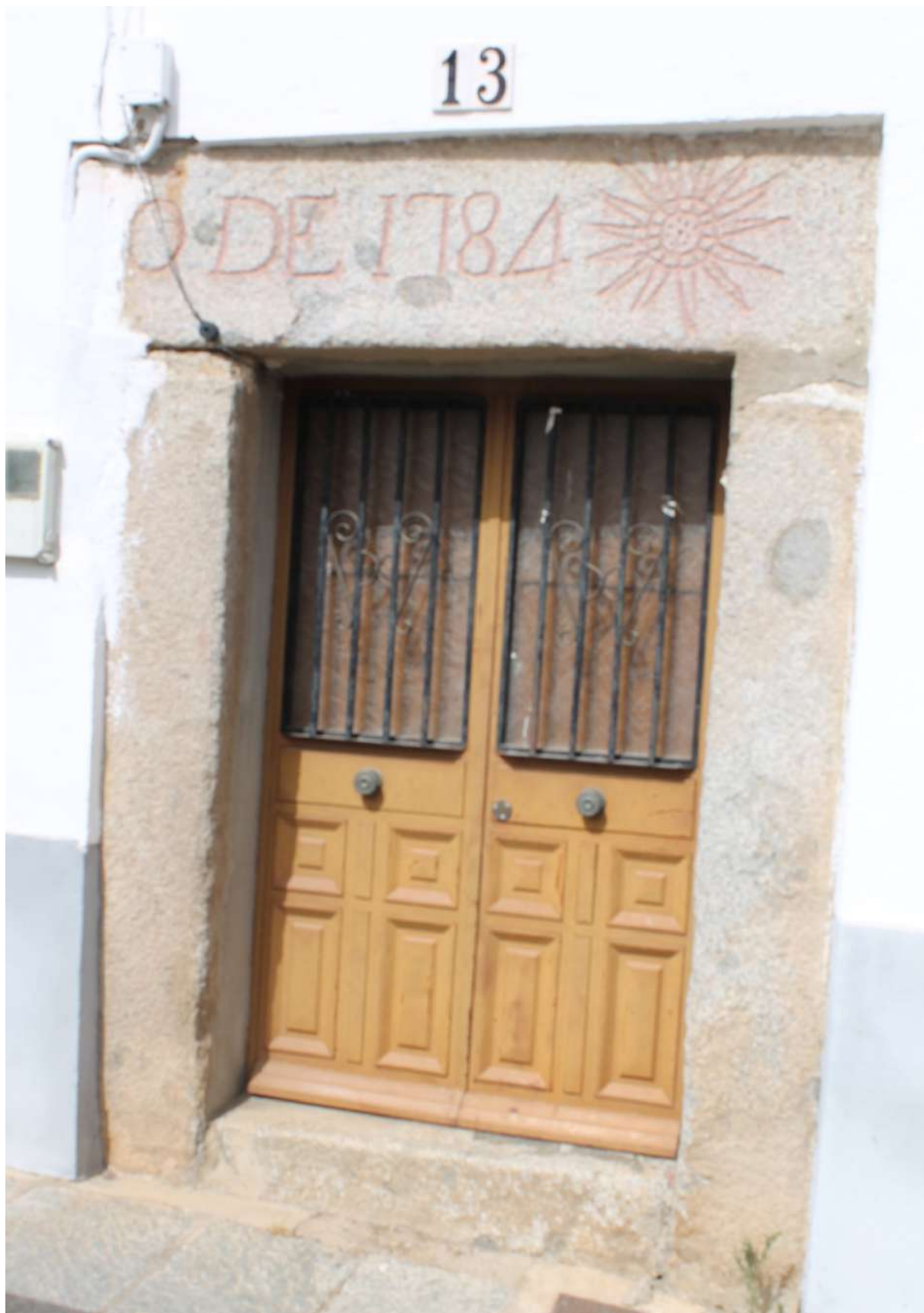
Dintel de 1784 * Calle Maestro Miguel López, nº 13 – Zona III
