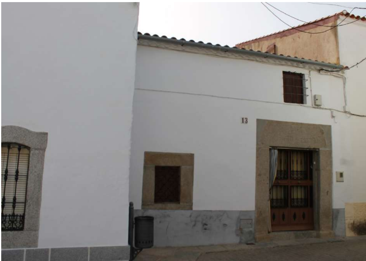
Fachada y dintel casa tradicional de Alcaracejos en calle Jesús nº 13
