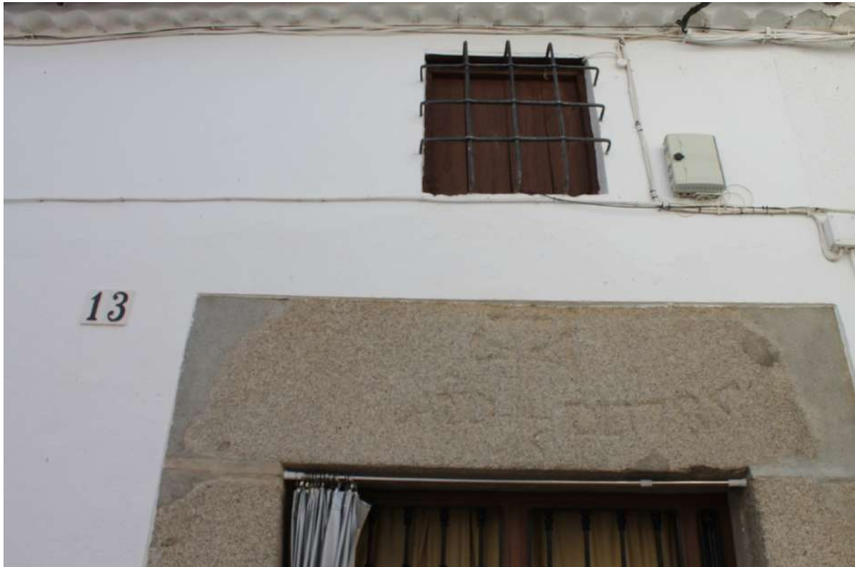
Detalle del dintel, casa nº 13 en Calle Jesús
