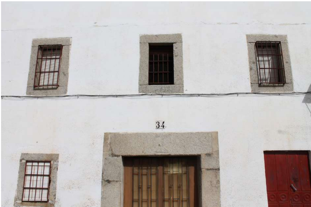
Fachada calle Nueva nº 34
