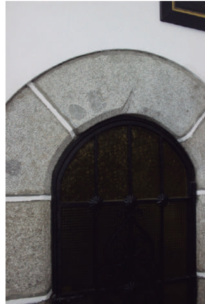
(Fig. 28) Fotografía autora. (Hinojosa del Duque, 2016). Pequeña puerta del interior de la parroquia, de estilo gótico de la Iglesia de San Juan Bautista de Hinojosa del Duque. Compuesta de sillares y con un pequeño conopio en la parte superior. Similitud con el estilo de la parroquia de Alcaracejos.
